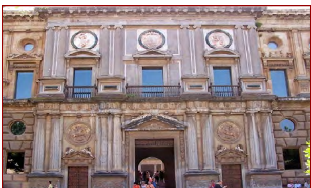
Detalle de la primera planta de la portada de la fachada principal
