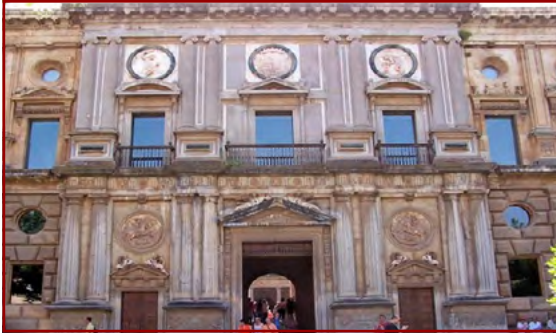
Detail des Obergeschosses der Hauptfassade
